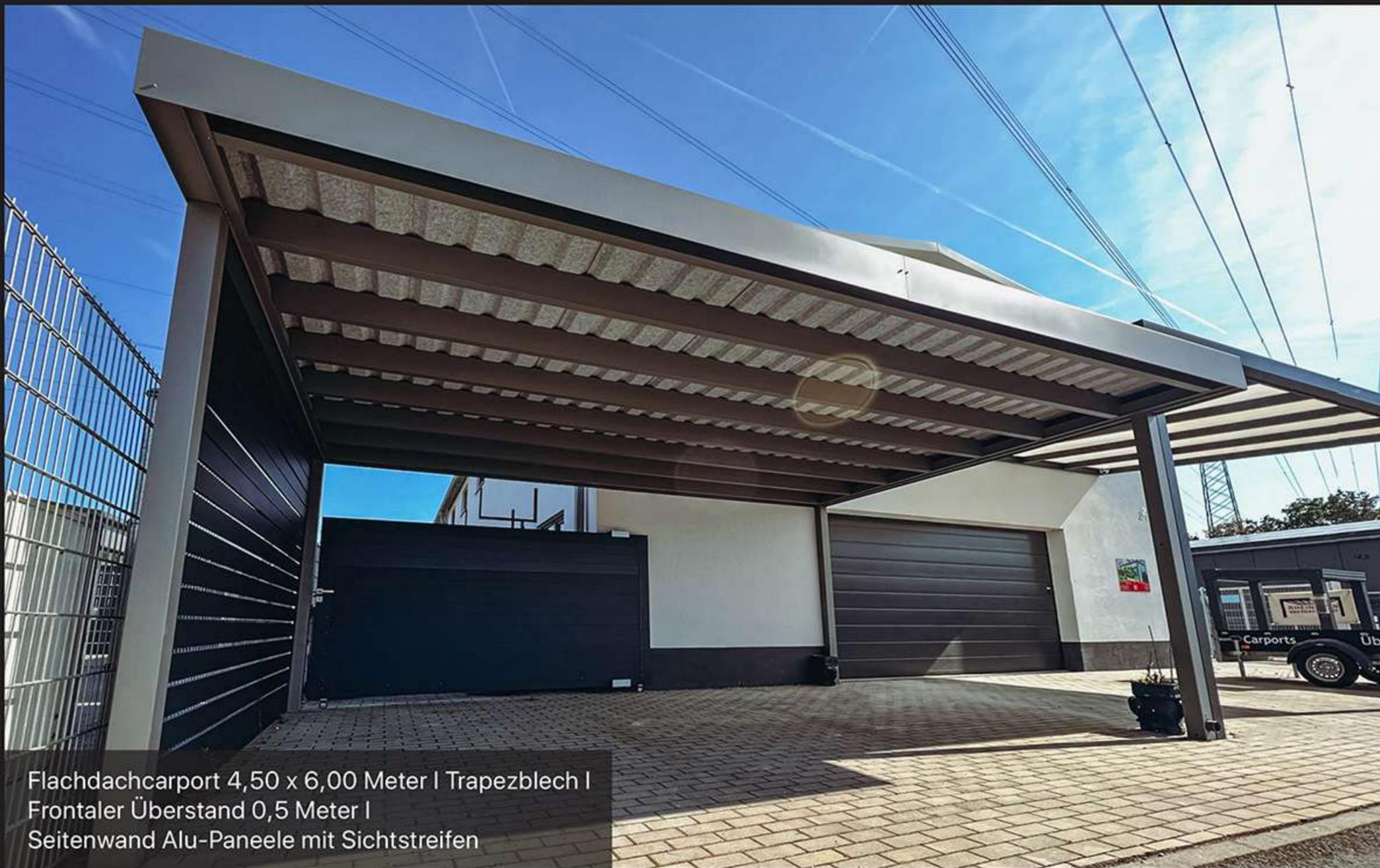
Flachdachcarport 4,50 x 6,00 Meter | Trapezblech |
